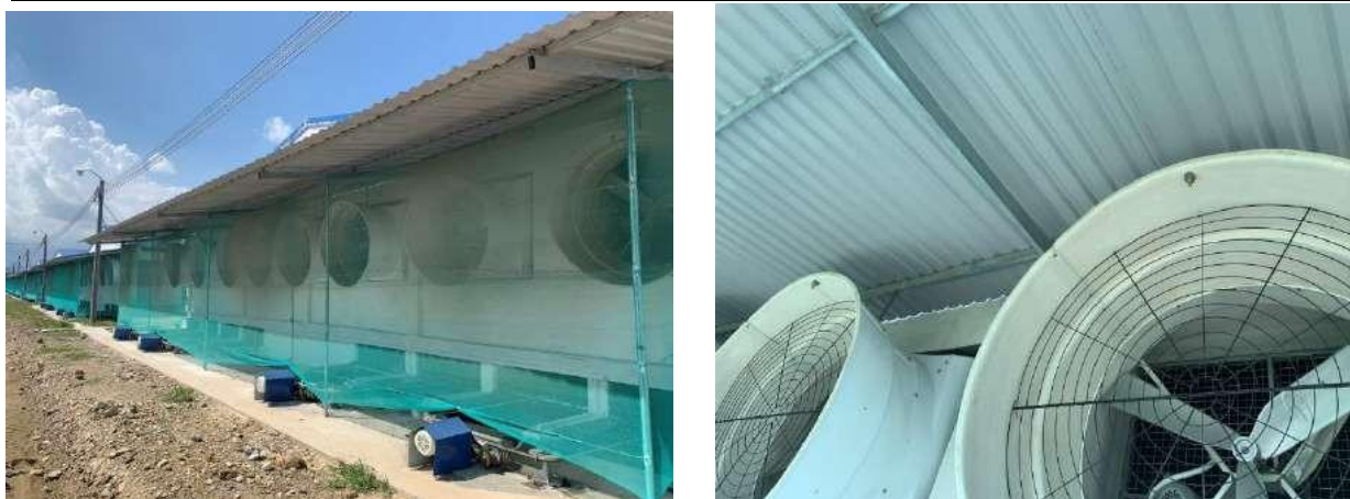
Hình 3. 9. Tham khảo bố trí béc phun sương và bọc lưới sau quạt hút để giảm mùi
