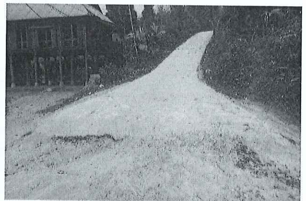
Km 4+256: Bắt đầu đoạn đường đất
