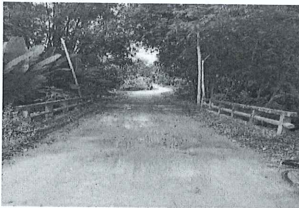
Km2+343,80: Tuyến đi qua cầu
