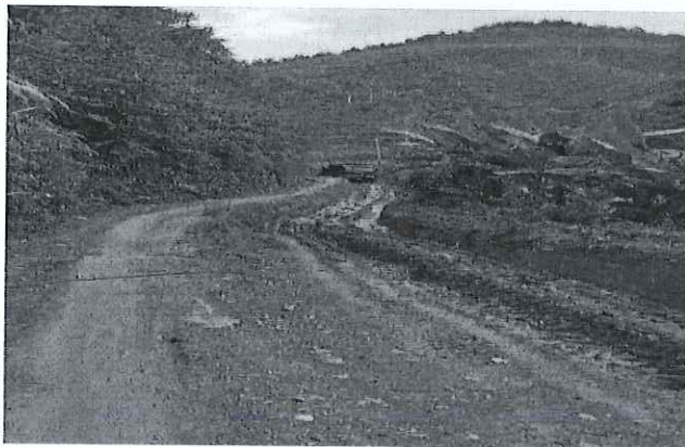
Km 5+500: Đoạn đường đất
