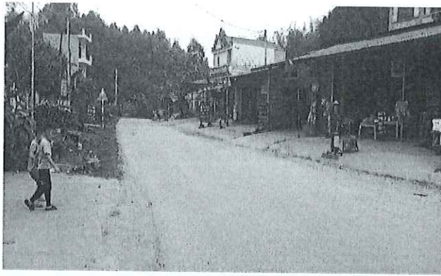
Km 0+000: Đoạn đầu tuyến giao QL.279
